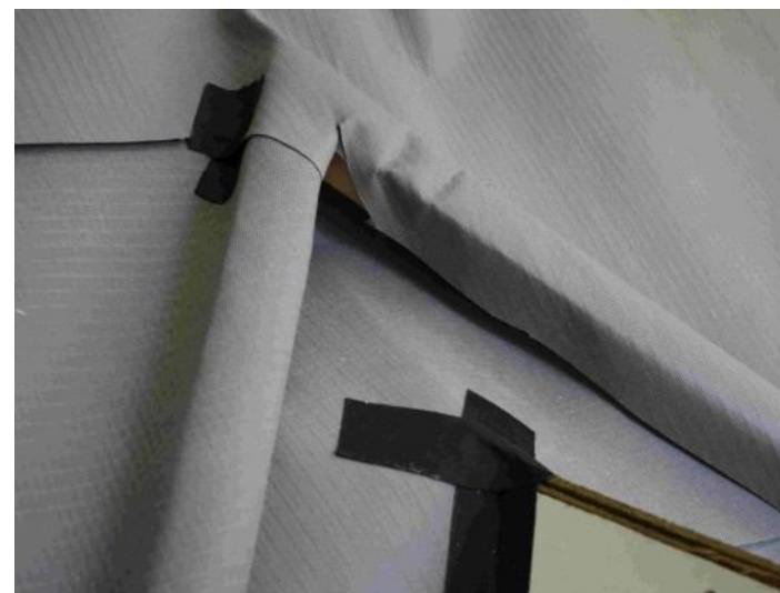
12.13 detail přilepení přesahu u hřebene střechy vikýře a upevnění membrány na kontralatě
